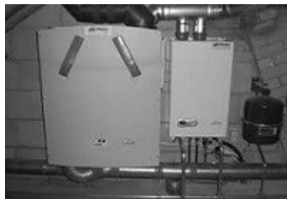
Afbeelding 2 installatie voor balansventilatie
