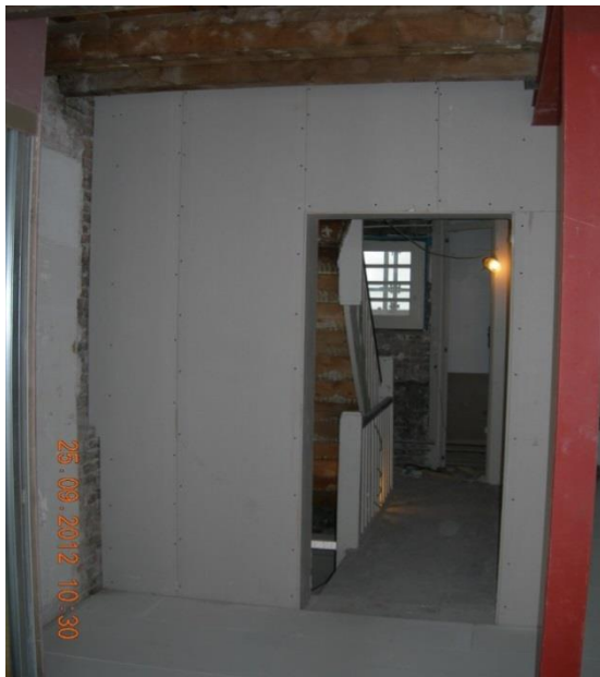
Foto: Woning in complex Indische Buurt tijdens de renovatie
