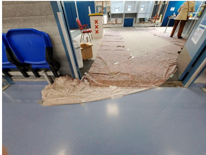
Foto: voorbeeld van niet-deugdelijke vloerbescherming.
